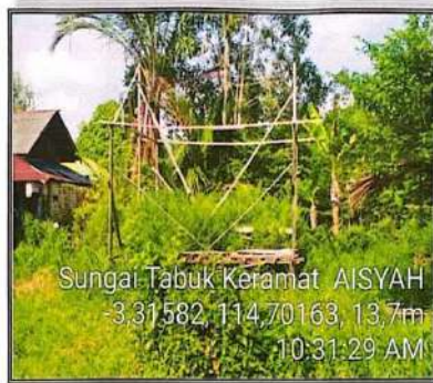
IDENTIFIKASI KERUSAKAN RUMAH AKIBAT BENCANA ALAM DESA SEI TABUK KERAMAT
